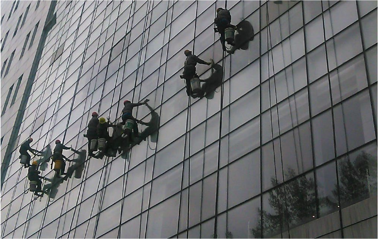
高空外墙清洗
